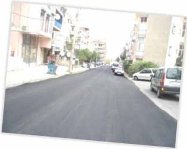
Narbel Yolu Kaymaz Asfalt Uygulaması
